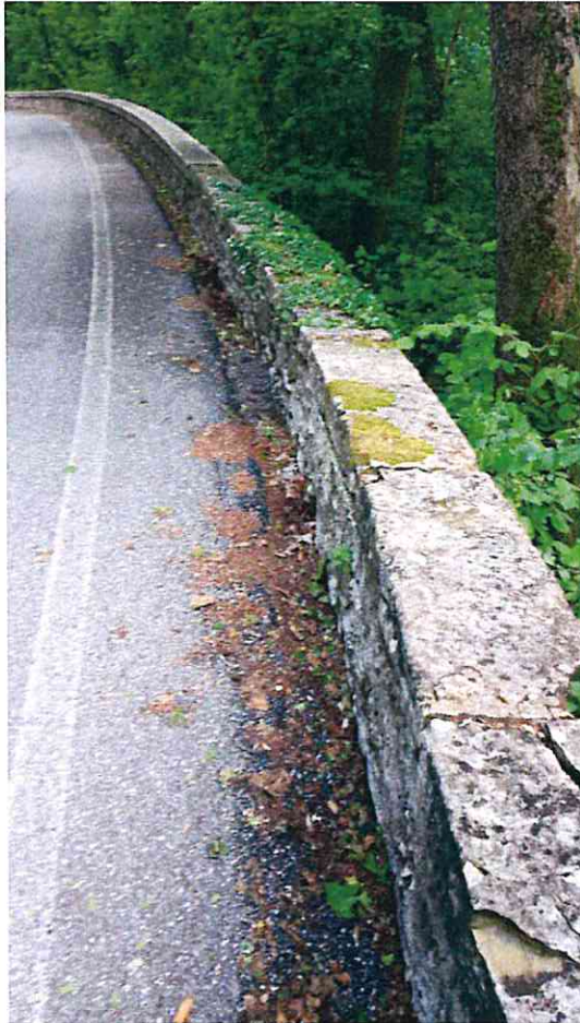
SPANCIAMENTO DELLA SOMMITA' E FESSURAZIONE DEI CIGLI ASFALTO A MONTE E A VALLE
