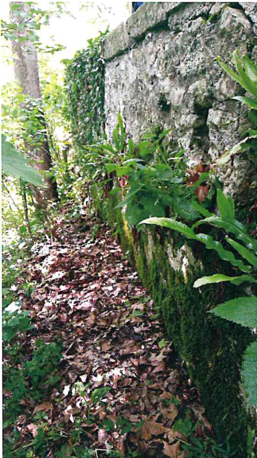
PARTICOLARE FIANCO MURATURA SI NOTI CHE IL TRATTO' IN CLS PROBABILMENTE E' CONSEQUENTE A UN PRECEDENTE CROLLO
