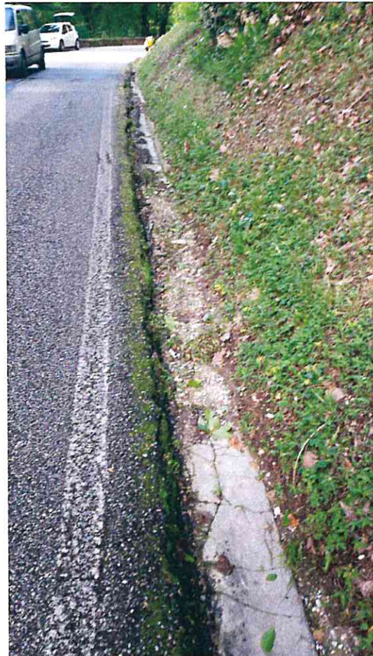
SPANCIAMENTO DELLA SOMMITA' E FESSURAZIONE DEI CIGLI ASFALTO A MONTE E A VALLE
