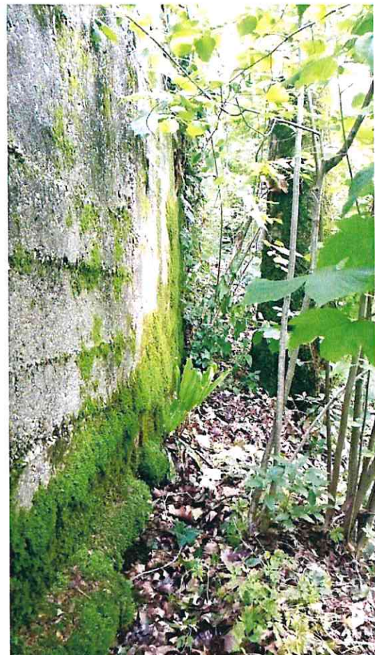
PARTICOLARE FIANCO MURATURA SI NOTI CHE IL TRATTO' IN CLS PROBABILMENTE E' CONSEQUENTE A UN PRECEDENTE CROLLO
