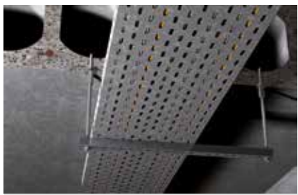
Solai in calcestruzzo alveolare precompresso
