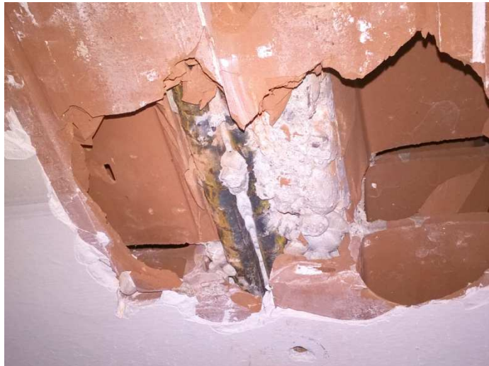
Foto dell'indagine stratigrafica della struttura del soffitto dell' aula A.
