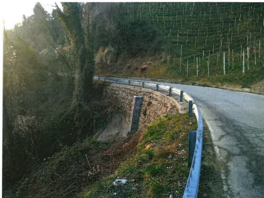
Figura 1: intervento lungo SP152 al km 15+870.
