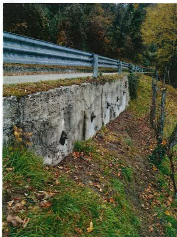
Figura 3: intervento lungo SP152 al km 16+120.
