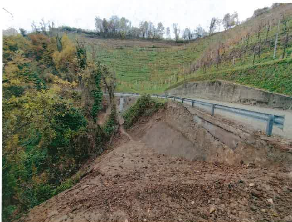
Figura 2: intervento lungo SP152 al km 15+950.
