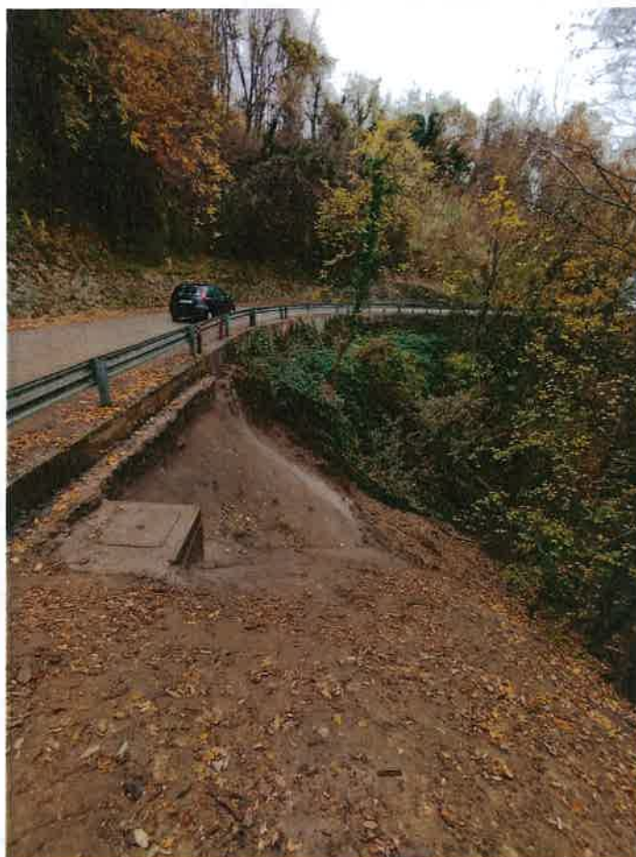
Figura 4: intervento lungo SP152 al km 16+350.
