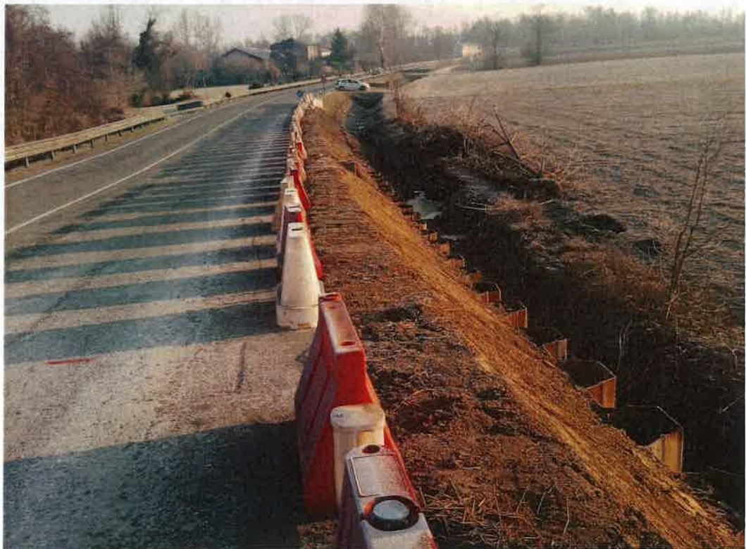
Allegato 5: ripristino della riva a lato della strada provinciale.
