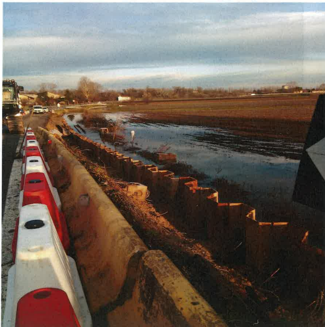
Allegato 4: palancolato metallico infisso nel terreno.
