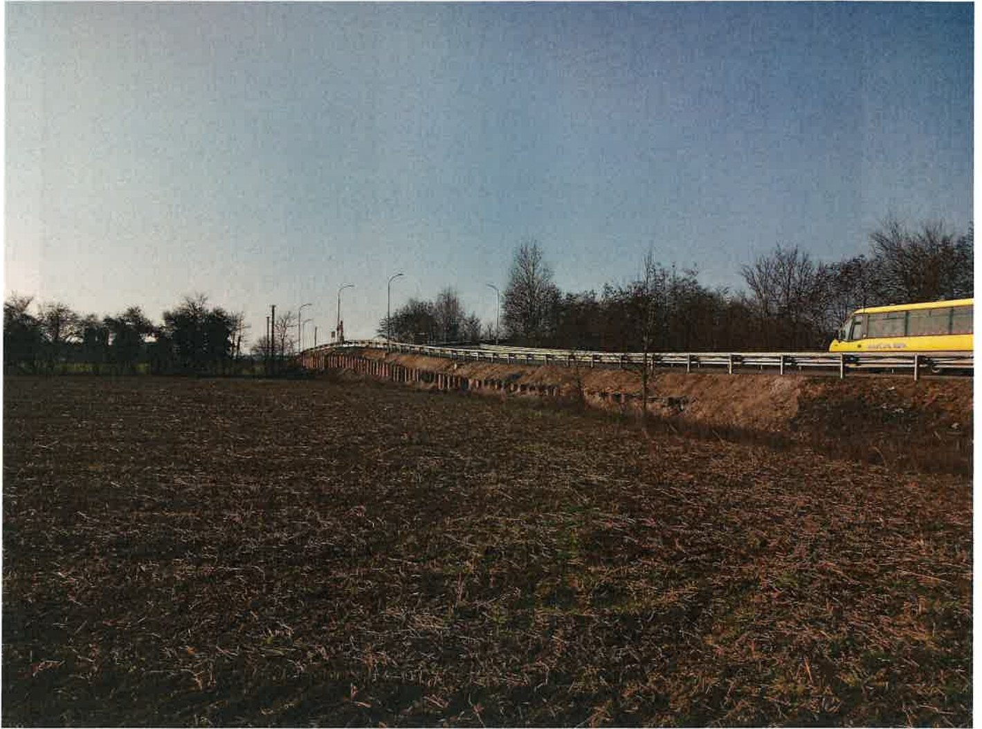
Allegato 6: vista dal lato campagna in seguito a ultimazione dell'intervento urgente.
